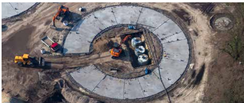
Bovenaanzicht van een wooncirkel in aanbouw (foto: Ik kan vliegen)
