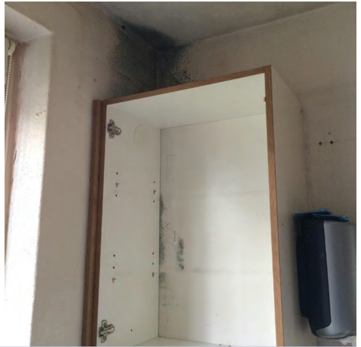
Deze keuken in een jaren 50-woning is al eens gerenoveerd, maar door woonvocht, onvoldoende ventilatie en verkeerd stookgedrag ontstaat condensatie op de koudste plaatsten in de woning.
