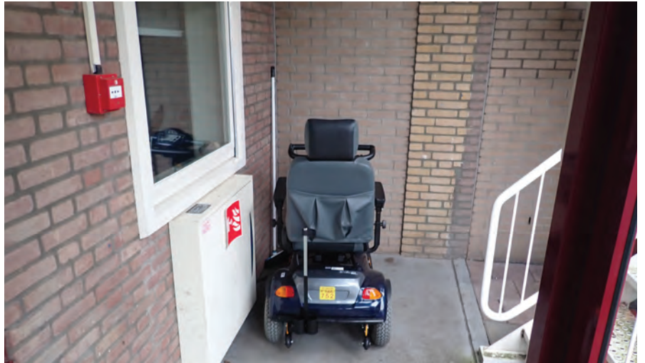
Winters: "Scootmobiel staat steeds vaker op de gang. Als de accu in brand vliegt, is onmiddellijk de vluchtweg geblokkeerd. Levensgevaarlijk"
