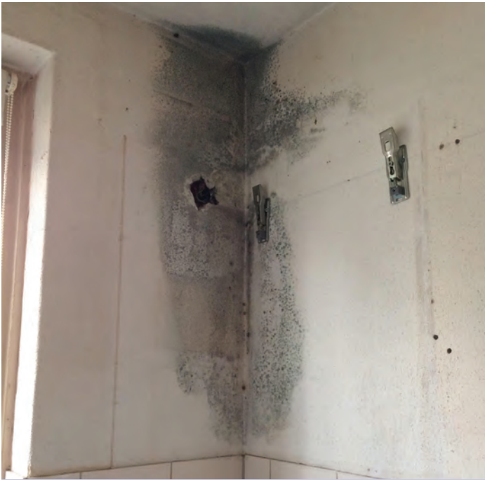
Deze keuken in een jaren 50-woning is al eens gerenoveerd, maar door woonvocht, onvoldoende ventilatie en verkeerd stookgedrag ontstaat condensatie op de koudste plaatsten in de woning.
