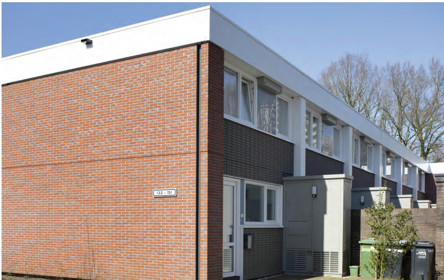
NOM-gerenoveerde woningen in Emmerhout, met installatie-unit tegen de achtergevel
