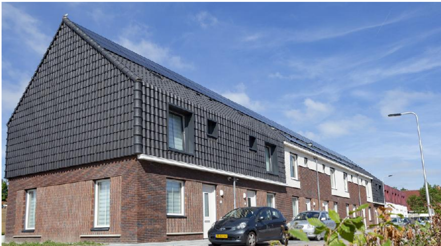
De zeer energiezuinige EPV-woningen in de Siemensstraat in Leerdam
