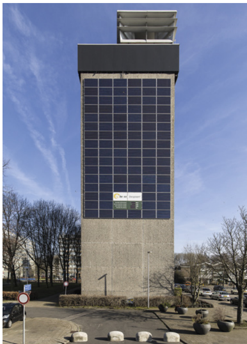
Flat 'Henriëttedreef' (Utrecht-Overvecht) met energievoorziening via dak, kopgevel en langsgevel
