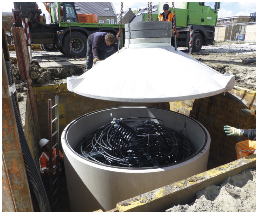
Plaatsing van eerste IJsbuffervaten in Goes-West
